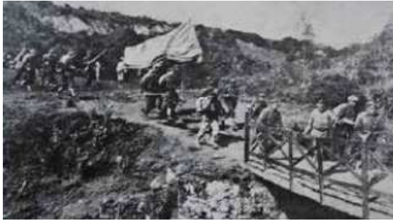
Imagen 7: puente de riostras de madera tomado revisita digital: desde la u 49
