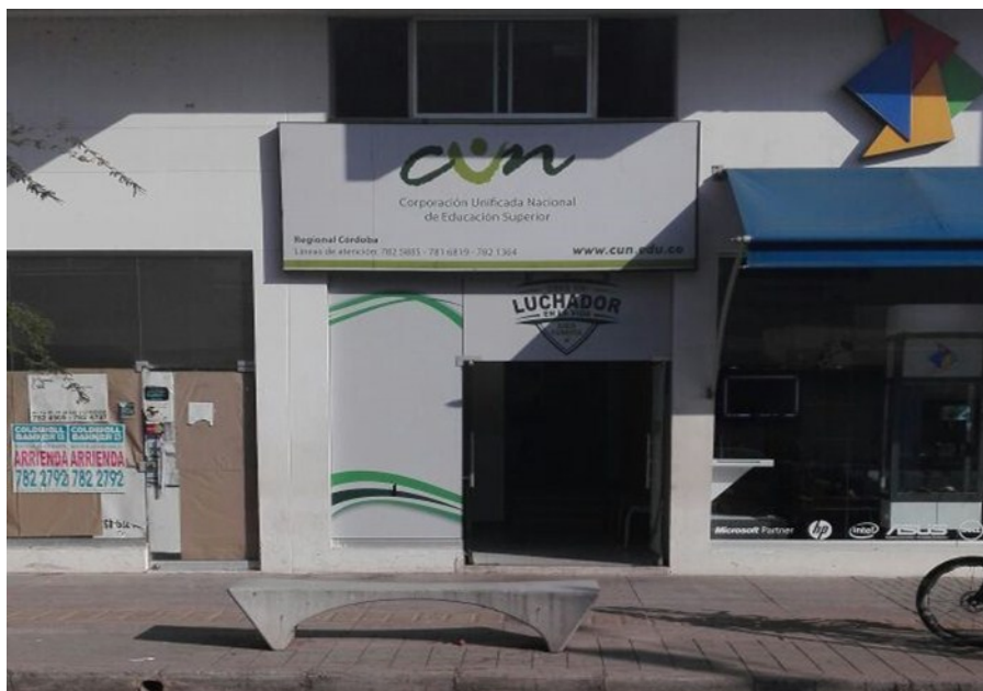
Imagen 1. Fachada de la institución
