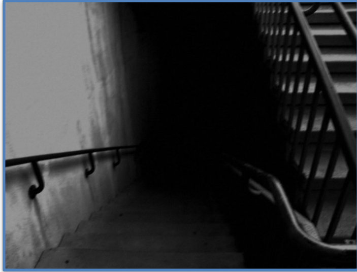
Escaleras hacia el sótano de una casa.
